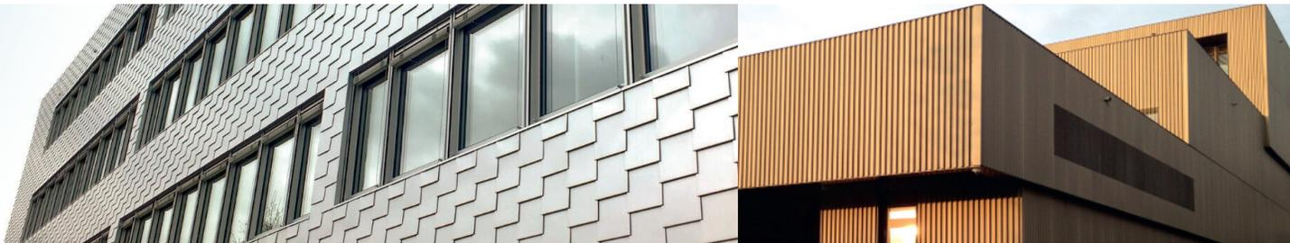
**hm-eloflex®** ist eine innovative Form der modernen Bandeloxierung. Die hier erzeugte metallische Oberfläche ist funktionell und begleitet Materialverformungen ohne wesentliche Beeinträchtigungen der Eloxalschicht.
